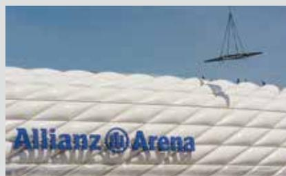
Mehrere Dachelemente sollten entfernt und durch ein FLEDMEX®-Lamellendach Allwetterdach ESCO® ersetzt werden. Weil jedes Projekt seine ganz besonderen Voraussetzungen mit sich bringt, wird bei uns jedes Dach gemäß seinen statischen Anforderungen individuell konstruiert. Das war bei diesem Projekt natürlich von besonderer Bedeutung, denn wo viele Menschen zusammenkommen, ist die Stabilität zum Beispiel bei schweren Schneelasten ein lebenswichtiges Kriterium. Damit die 75.000
